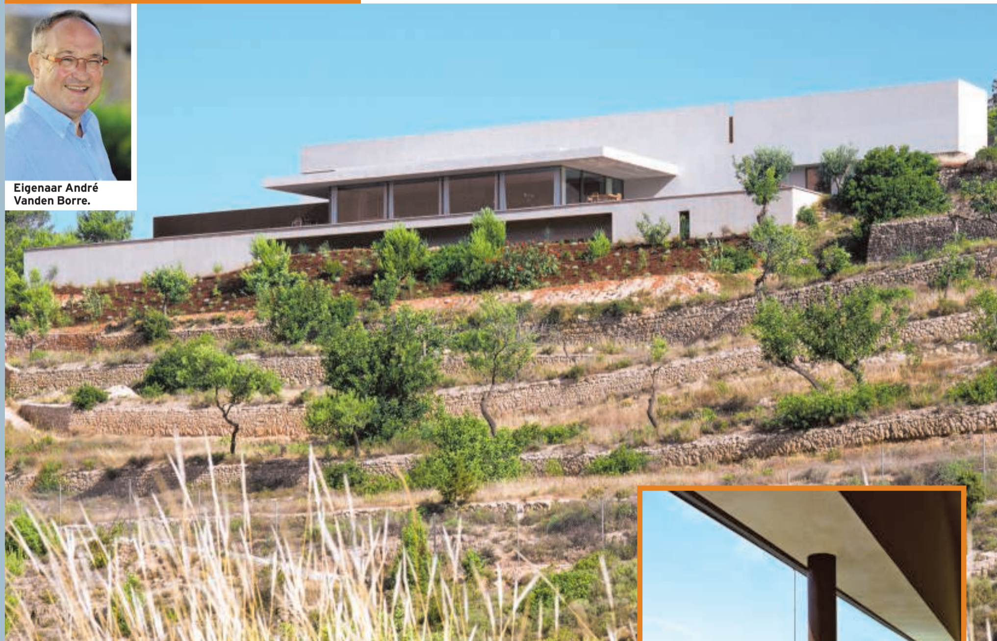
De horizontale lijnen van de terrassen komen terug in de strakke architectuur van de villa. Foto's Jean-Luc Laloux
